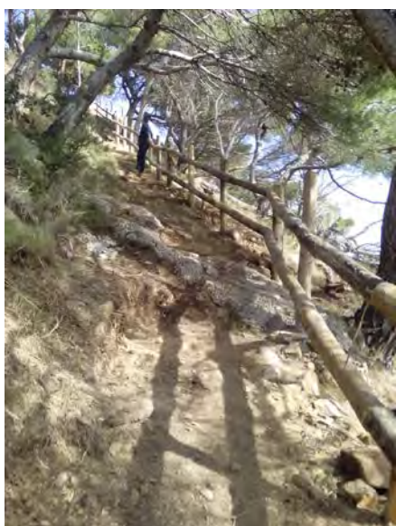
Millora de l'entorn de Cala Marquesa
